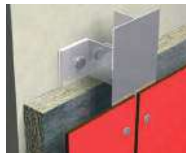
Pose sur ossature métallique
